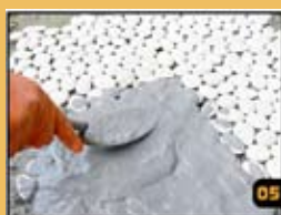
Il est recommandé de sceller les pierres avec un scellant pénétrant avant la pose du coulis à joint et également après la pose et la prise du coulis à joint.
