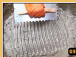
Appliquer le mortier avec une truelle dentelée de 1/4". La pose d'une membrane imperméabilisante est fortement recommandée dans les endroits humides.
