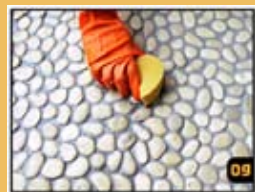
Passer l'éponge sur les pierres jusqu'à l'obtention du fini désiré. Une fois que le coulis aura complètement séché, sceller les pierres avec un bon scelleur pénétrant. Des rehausseurs de couleur et de lustre peuvent également être utilisés. Suivre les instructions des fabricants.
