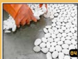
Abouter chaque carreau contre les autres sur le lit de mortier. Presser légèrement les pierres en place sans toutefois les enfoncer dans le mortier. Attendre le temps recommandé par le fabricant du mortier avant de sceller ou de poser le coulis à joint afin d'éviter de disloquer les pierres.
