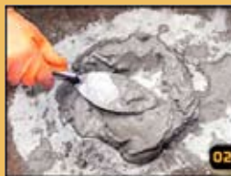
Utiliser un mortier pour pose en lit mince de première qualité.
