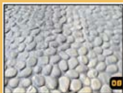
Attendre que le coulis ait le temps de bien combler les espaces entre les pierres avant de l'essuyer avec un éponge.
